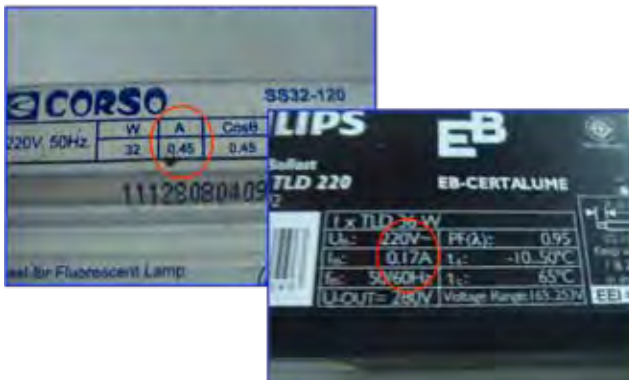
บาลาสต์อิเล็กทรอนิกส์แทนบาลาสต์แกนเหล็ก
